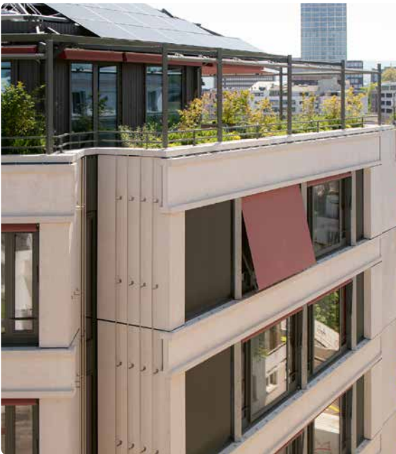
Blick auf die Dachterrasse, Haupthaus «irides»
